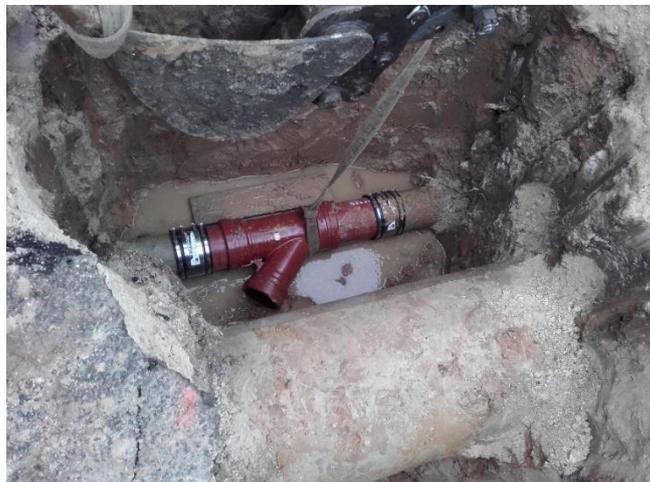
FIGURE 7 : CULOTTE DE RACCORDEMENT
